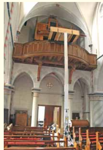
beim Abbau der Orgel
